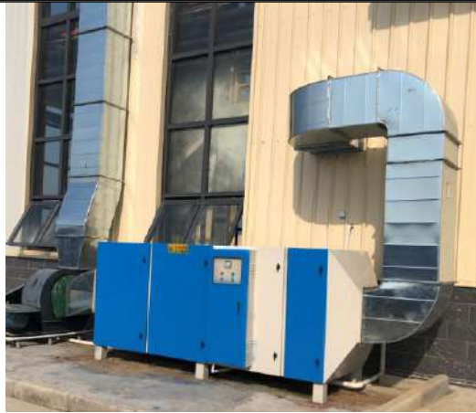
1#现有注塑废气处理 (UV 光解+活性炭吸附)
